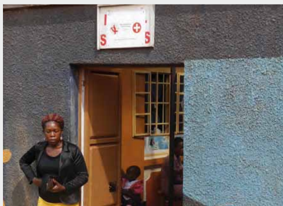
Bereits am nächsten Tag wird das neue Schild über das bestehende Schild montiert.
