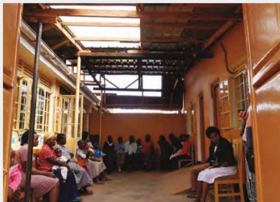
Der Eingangsbereich wurde überdeckt und renoviert und dient nun als grosszügiges Wartezimmer. Somit konnte im Innern ein 2. Behandlungsraum geschaffen werden.
